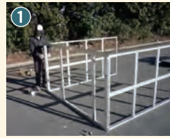
① 床・屋根パネルにサイドパネルを4面ボルトで固定します。
