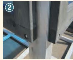
② サイドパネル用アルミフレームにボルトを使ってアクリルパネルを取付けます。
