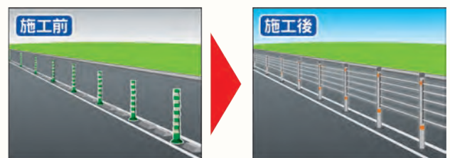
BA-6013 (防護柵設置工事)
