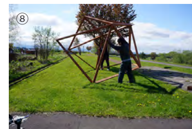
⑧ 残りのパーツを取り付けやすい位置に転がします。
