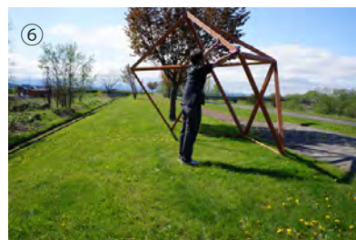
⑥ 支えながら9個目、10個目を付けていきます。
