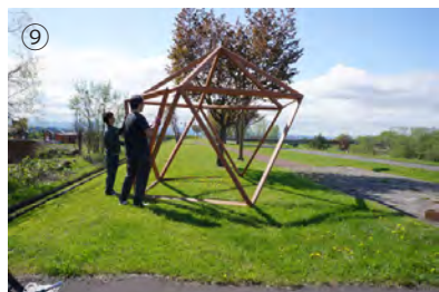
⑨ 11個目～14個目を取り付けて骨組み完成です。
