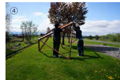
④ 角を持ち上げながら三角パーツ6、7個目を取り付けます。
