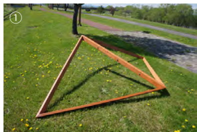
① 三角形のパーツ同士をボルトで連結します。
