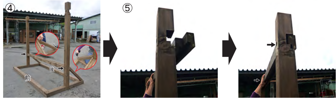
【横柱】 × 上1本、下1本 ※溝の深さは上30mm、下15mm
